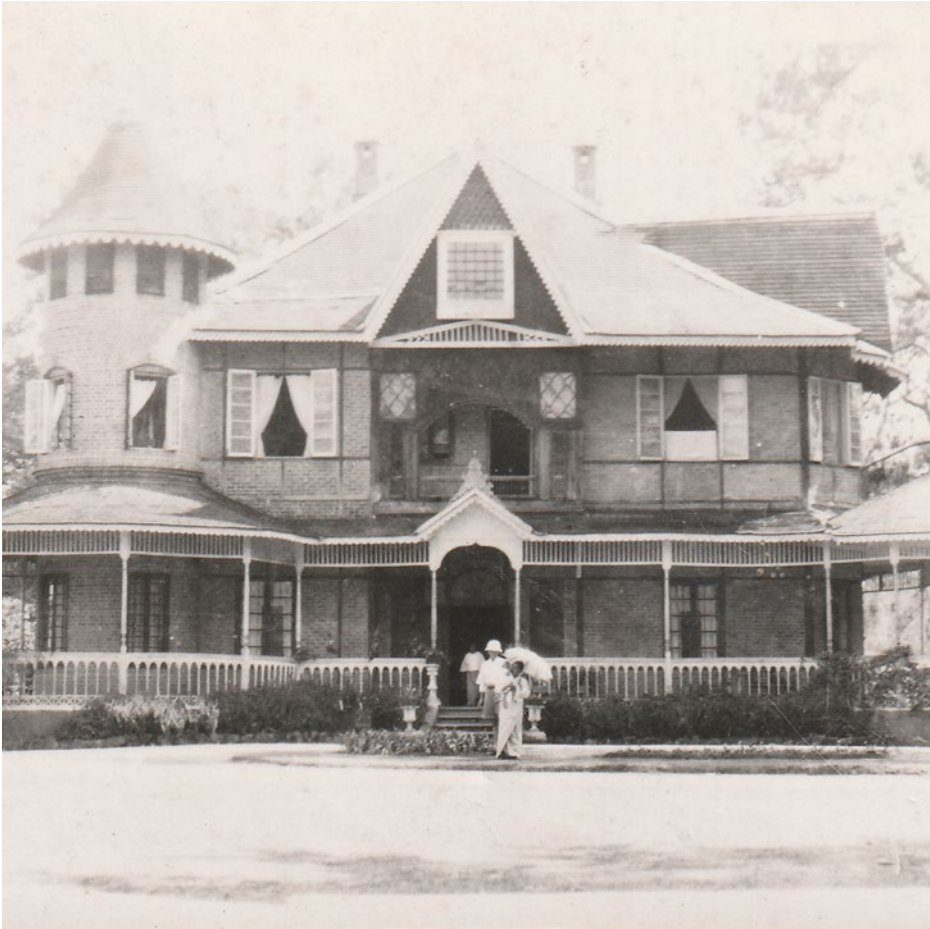
Herbert Bellamy e la principessa Ma Latt davanti alla Gandama Myaing, la loro prima casa di Maymyo. L'edificio esiste ancora e si trova vicino al giardino botanico Kandawgyi.
